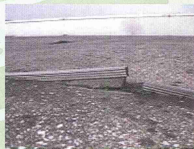
◆目地材の飛び出し
